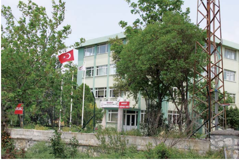
■ ■ ■ SADAT A.Ş. Merkez Binası
